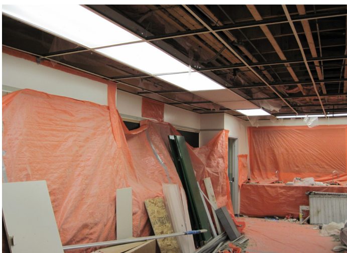
Il faut prendre des mesures pour éviter la migration de la poussière et autres contaminants
