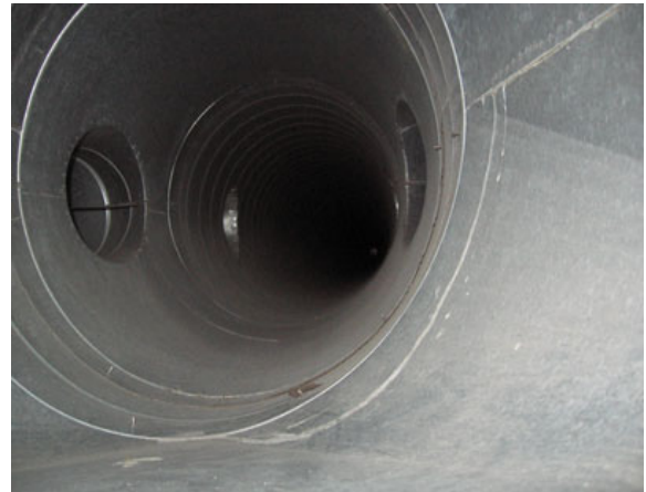
Gaine après nettoyage
