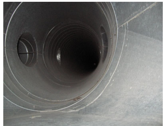
Photo 6 - Conduit après nettoyage
